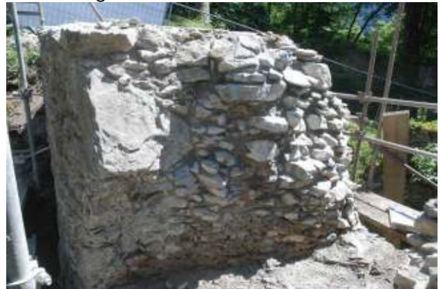
NWR11 , Schießscharte mit fehlender Tuffsteinleibung auf beiden Seiten. An der Außenseite ist ein Rest zu erkennen. Der flache große Stein stellt den ehemaligen Entlastungsbogen dar.
