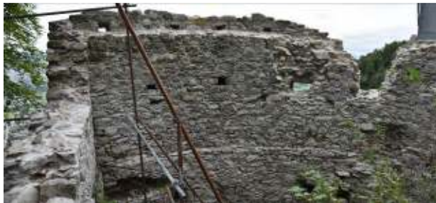
Fertig gestellte Mauerschale der Nordmauerinnenseite, Foto 2017.
