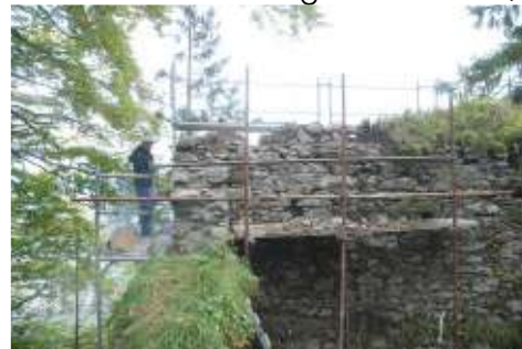
Während der Restaurierung mit den Balkenlöchern NWR12a,b , Innenseite, Foto 2015
