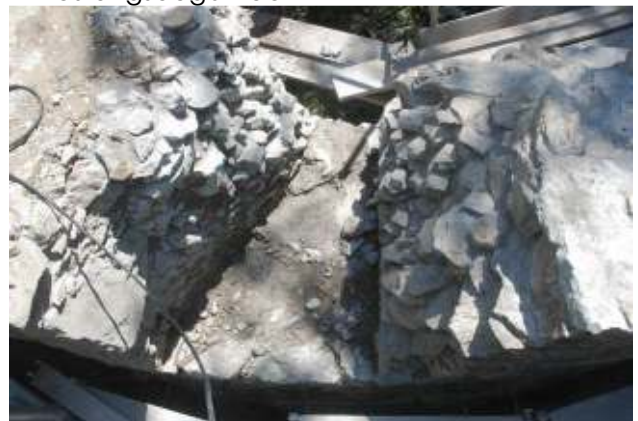
NWR11 , Zustand nach der Restaurierung von außen nach innen. Die innere Trichterung ist abgegangen.
