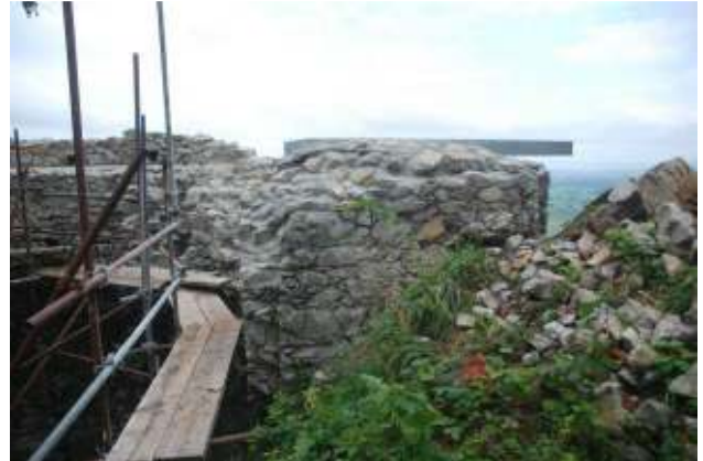
Fertige Sanierung der Mauerkrone, Foto 2016
