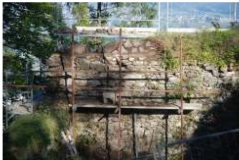
Während der Freilegung, Innenseite, Foto 2015
