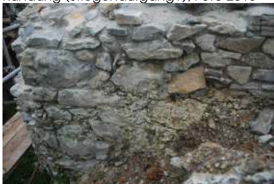
Befundpunkt NWR08 gefärbte Oberfläche an der Leibung des Durchgangs direkt auf den Steinen ohne Putz. (Die Farbe ist weiß Richtung
