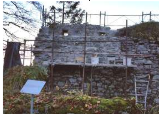
Fertig sanierte Mauerkrone, Innenseite, Foto Stephan Moosbrugger 2015
