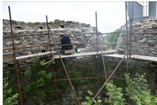
Beginn der Sanierungsarbeiten im Mai 2017.
