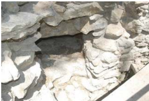
NWR10 , Zustand nach der Restaurierung Innen. Die innere Trichterung ist abgegangen.
