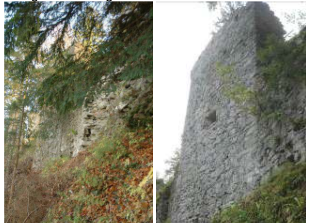
Vorher Die Außenseite gegen Nord vor der Sanierung 2005 und heute, Foto 2016
