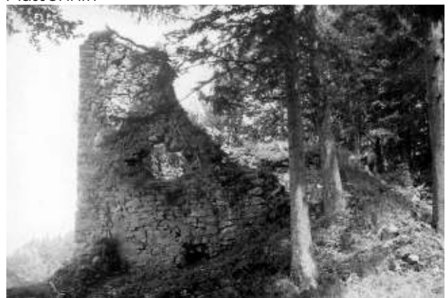
NW-Rondell Nordseite von Alt-Ems um 1950. Der westliche Teil (rechts) ist noch etwas höher. Bei genauerer Betrachtung sind drei weitere Balkenlöcher (Rüstlöcher) an der Mauerkrone beobachtbar. Foto Franz Dieth S41 (Dieth 1994), Ausschnitt
