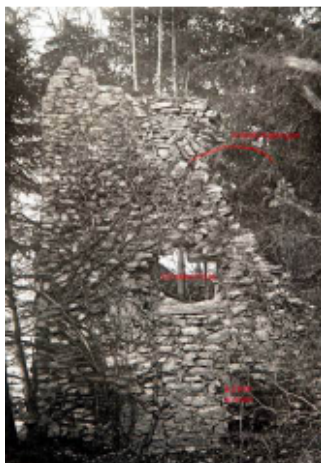
NW-Rondell Westseite, um 1900, Die Schießscharte ( NWR03 ) im Erdgeschoss ist noch relativ gut erhalten. Es zeichnet sich im 1. Obergeschoss der Entlastungsbogen einer weiteren Schießscharte ( NWR13 ) ab. Diese ist nicht mehr erhalten. Fotosammlung Familie Banzer.
