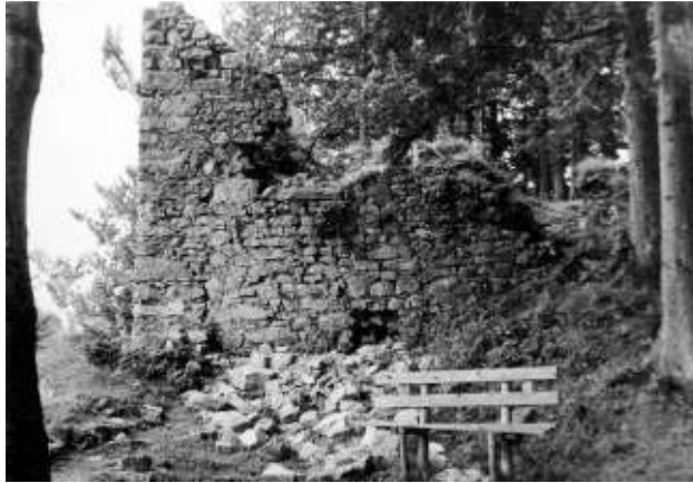
NW-Rondell 1953, die Mauer ist zusammengebrochen. Foto Horst Jäger
