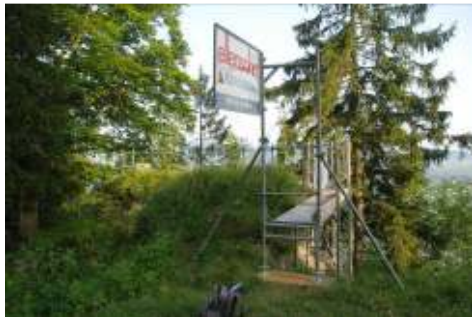
Außengerüst vor dem Beginn, Foto 2015
