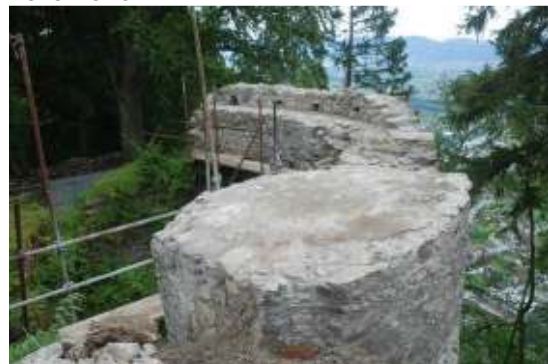
Das selbe während der Restaurierung, Foto 2016
