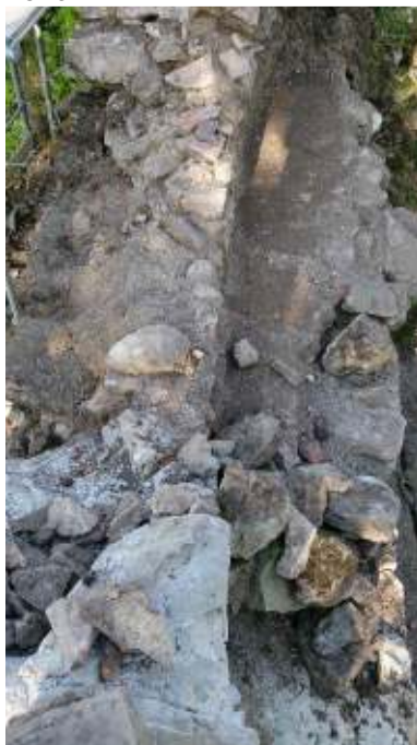
Original Oberfläche der Ausgleichschicht zwischen den Rüstlöchern NWR12c,d während der Freilegung von oben, Foto 2016
