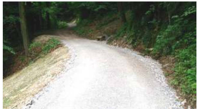
Fahrweg beim „Rauchenden Stein“ wiederhergestellt, Foto 2016
