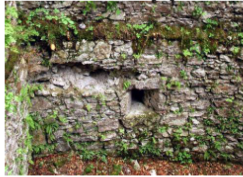
NWR04 Schießscharte an der Innenseite mit Prellholzlöchern für die Hakenbüchse. Foto 2005
