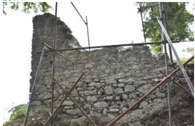
Fertig gestellte Mauerkrone und der obere Teil der Mauerschale der Westmaueraußenseite, Foto 2017.
