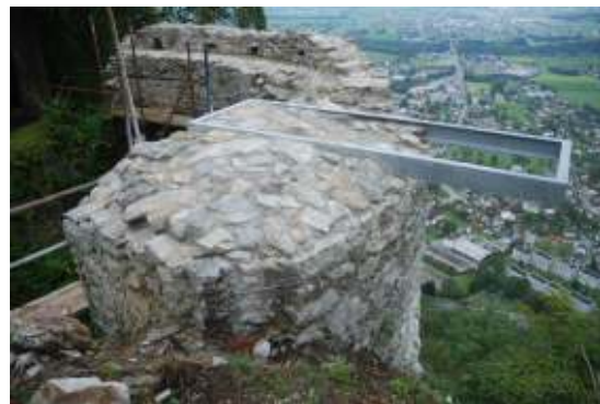
Mit aufgebracht Verschleißschicht und die Metallrahmen für den zukünftigen Aussichtsteg. Foto 2016
