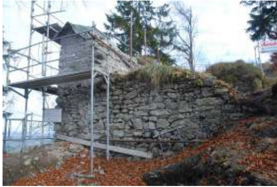
Fertig saniertes oberer Mauerteil, Hofwestseite, Foto 2015
