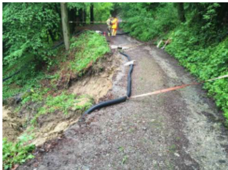
Fahrweg mit Grundbruch beim „Rauchenden Stein“, Foto Dieter Heidegger 2016
