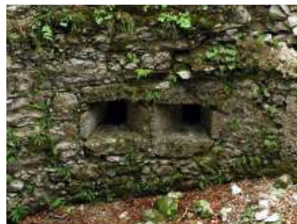
NWR05/06 zwei Schießscharten (Zwillingsscharte) an der Innenseite mit Ausnehmungen für den Haken der
