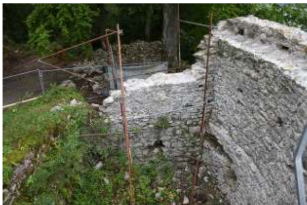
Fertig gestellte Mauerkrone und der obere Teil der Mauerschale der Westmauerinnenseite, Foto 2017.
