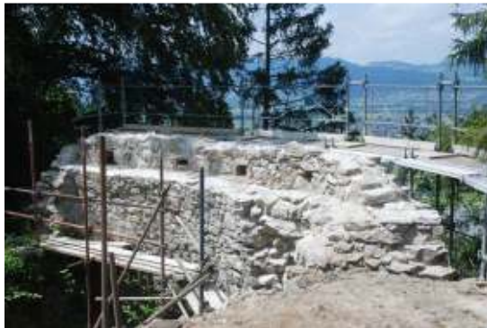
Die Situation mit allen restaurierten Rüstlöcher. Foto 2016
