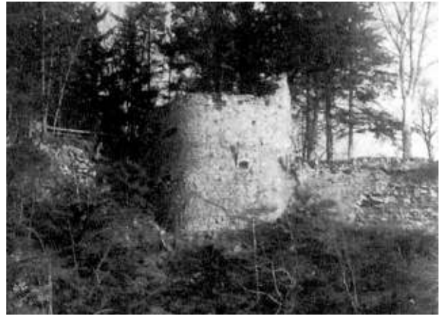
NW-Rondell Nordseite von Alt-Ems um 1950. Der westliche Teil (rechts) ist noch etwas höher. Bei genauerer Betrachtung sind drei weitere Balkenlöcher (Rüstlöcher) an der Mauerkrone beobachtbar. Foto Franz Dieth S41 (Dieth 1994), Ausschnitt
