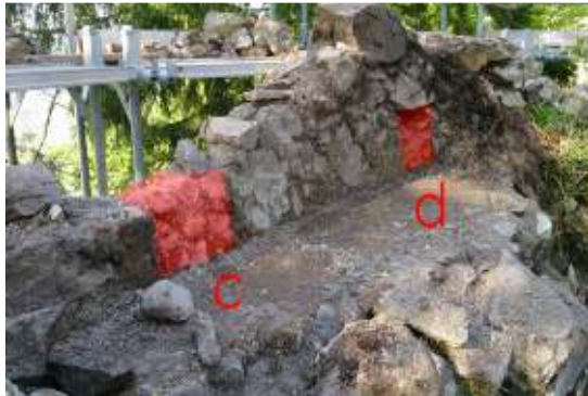
Befundpunkt NWR12c,d ; Zwei weitere freigelegte, aber vermauerte Rüstlöcher, Foto 2016
