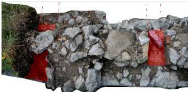
NWR12 Blick Richtung Süd, zwei Rüstlöcher
